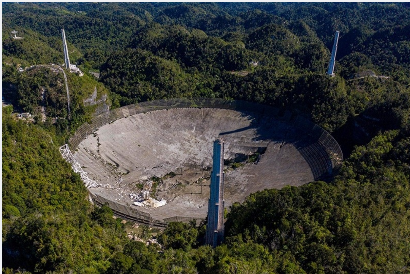
Телескоп Аресибо после падения инструментальной платформы. 1 декабря 2020 года
